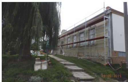
Zateplení a nová fasáda z čelní strany
