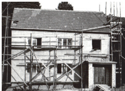
Přestavba staré „hasičárny“ na klubovnu
