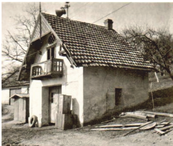
Špatný stav staré hasičárny ve svahu pod školou
